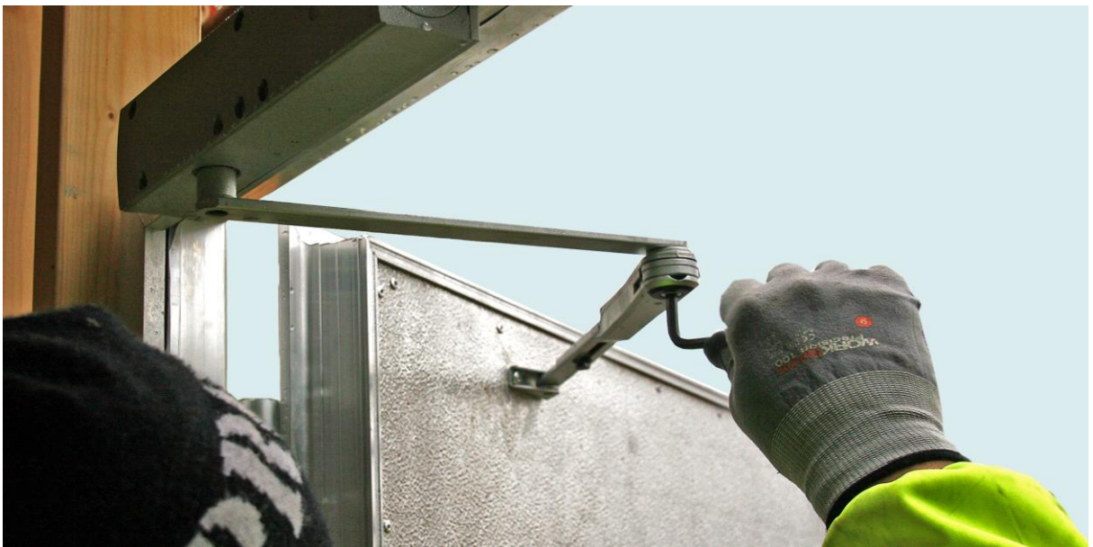
Skruva fast armen i dörrbladet
