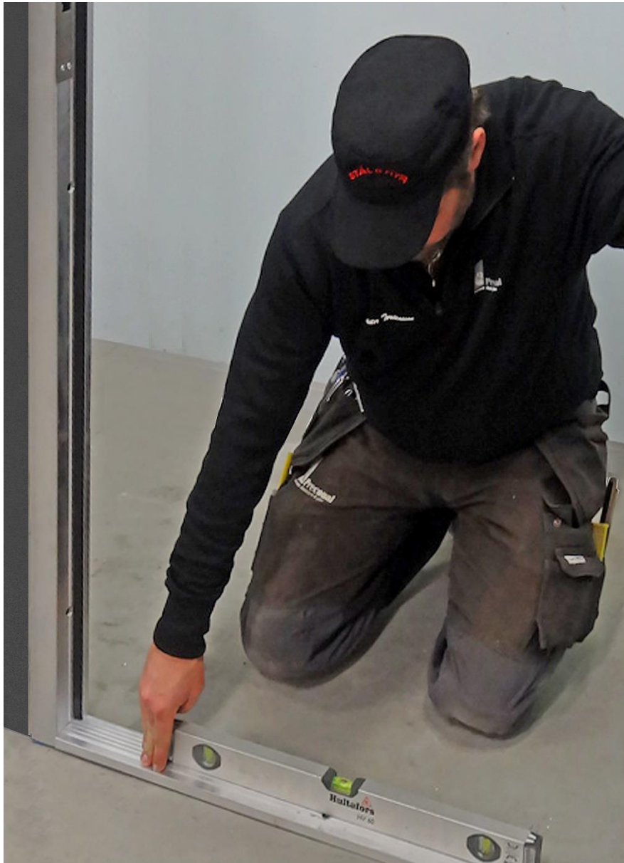
Väg av bottenplattan
