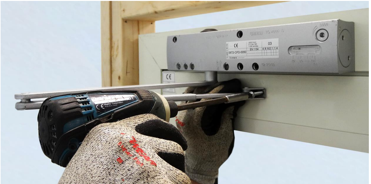
Skruva fast armen i dörrbladet
